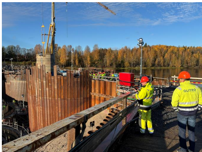
Study tour visit, spillway gate replacement project at Forshuvudforsen. Photo: Fortum
