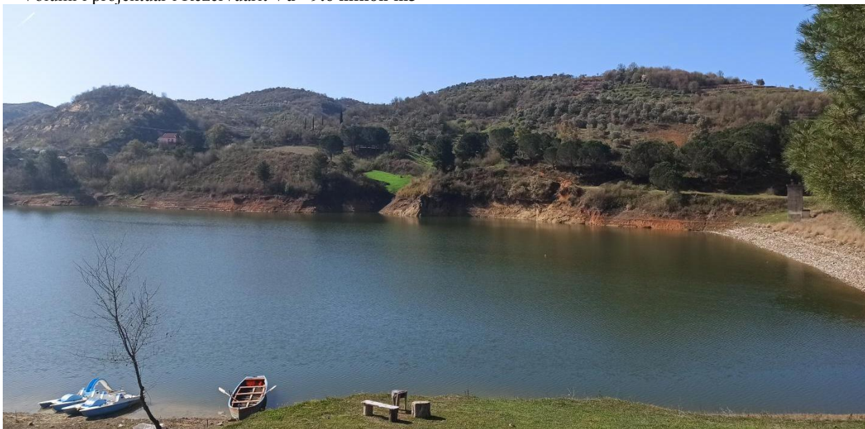
11- Diga dhe rezervuari i ujitjes ne Dofti -Bulo, Libohove,H= 18.0 m, Volumi i projektuar i Rezervuarit Vu= 12.6 milion m3
