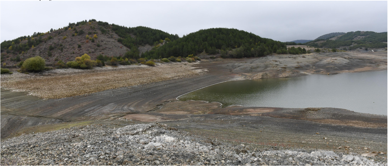
8- Diga dhe rezervuari i Ujitjes ne Kurjan-Strum, Roskovec, H=21.0 m, Volumi i projektuar i Rezervuarit Vu=31.5 milion m3
