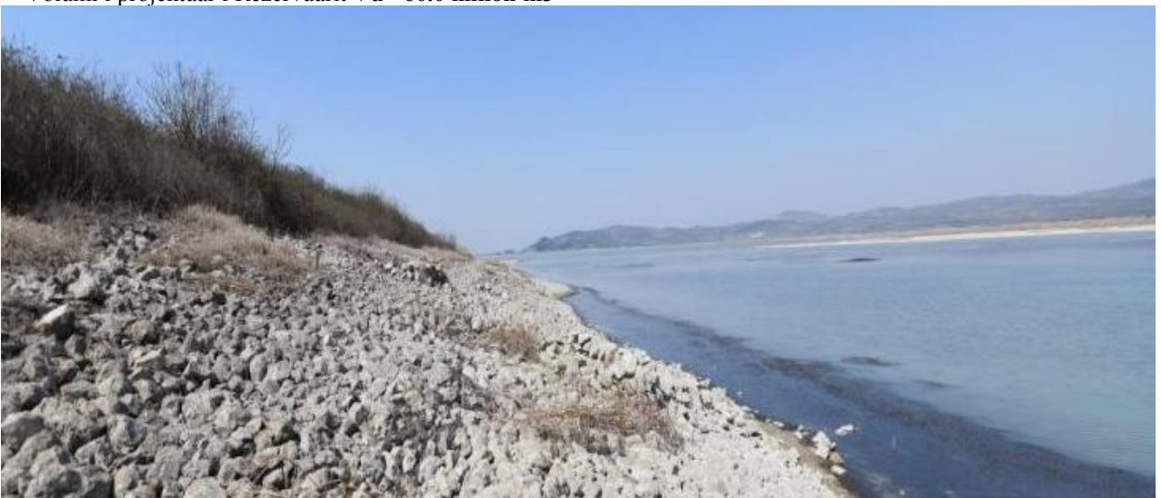
9- Diga dhe rezervuari i Ujitjes ne Murriz Thane, Lushnje, H= 12.46 m, Volumi i projektuar i Rezervuarit Vu= 60.0 milion m3
