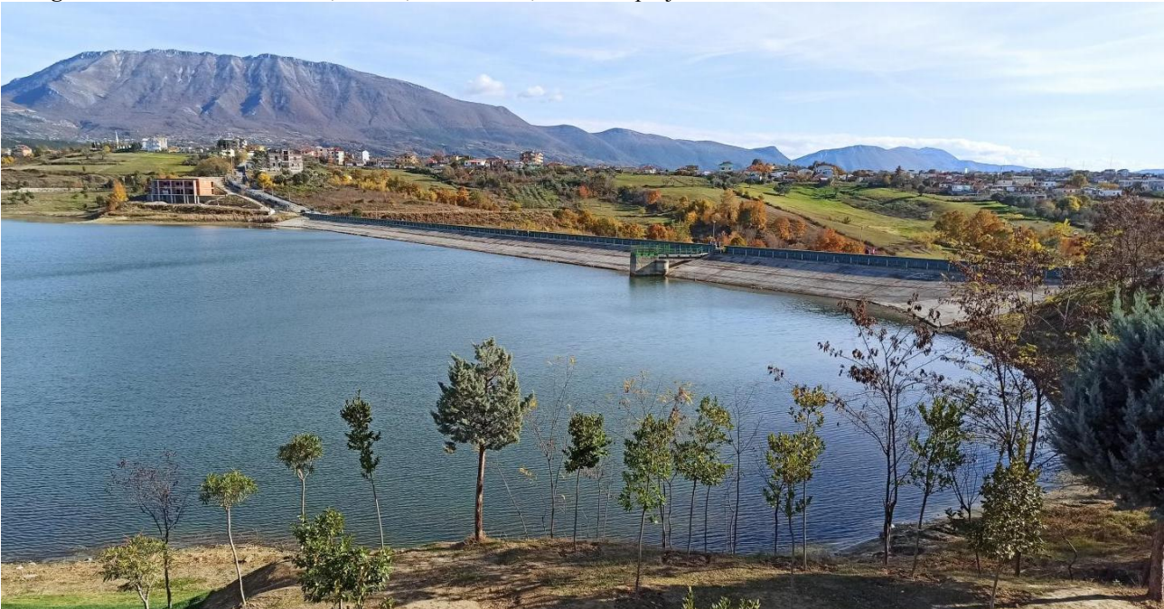
6- Diga dhe rezervuari i Ujitjes ne Koshnice, Devoll, H = 31.0 m, Volumi i projektuar i Rezervuarit Vu= 3.7 milion m3
