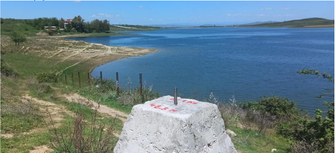
9- Diga dhe rezervuari i Ujitjes ne Murriz Thane, Lushnje, H= 12.46 m, Volumi i projektuar i Rezervuarit Vu= 60.0 milion m3
