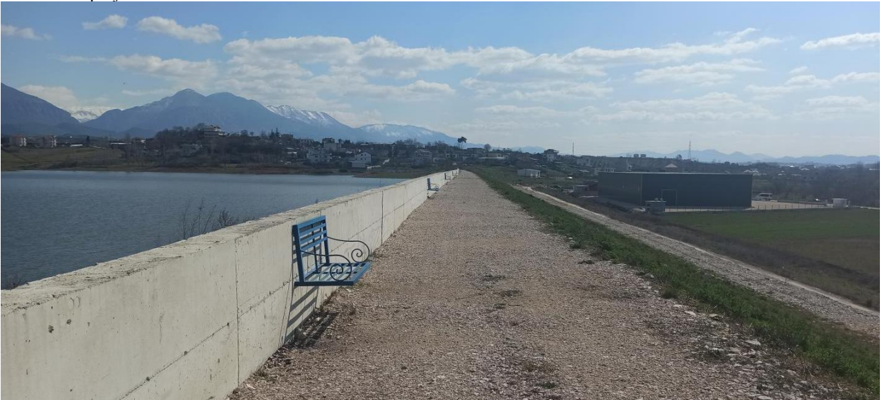
14- Diga dhe rezervuari ne Paskuqan, Kamze, H=28.0 m, Volumi i projektuar i Rezervuarit Vu=9.0 milion m3
