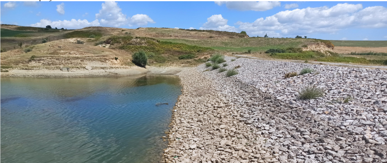
6- Diga dhe rezervuari i Ujitjes ne Koshnice, Devoll, H = 31.0 m, Volumi i projektuar i Rezervuarit Vu= 3.7 milion m3
