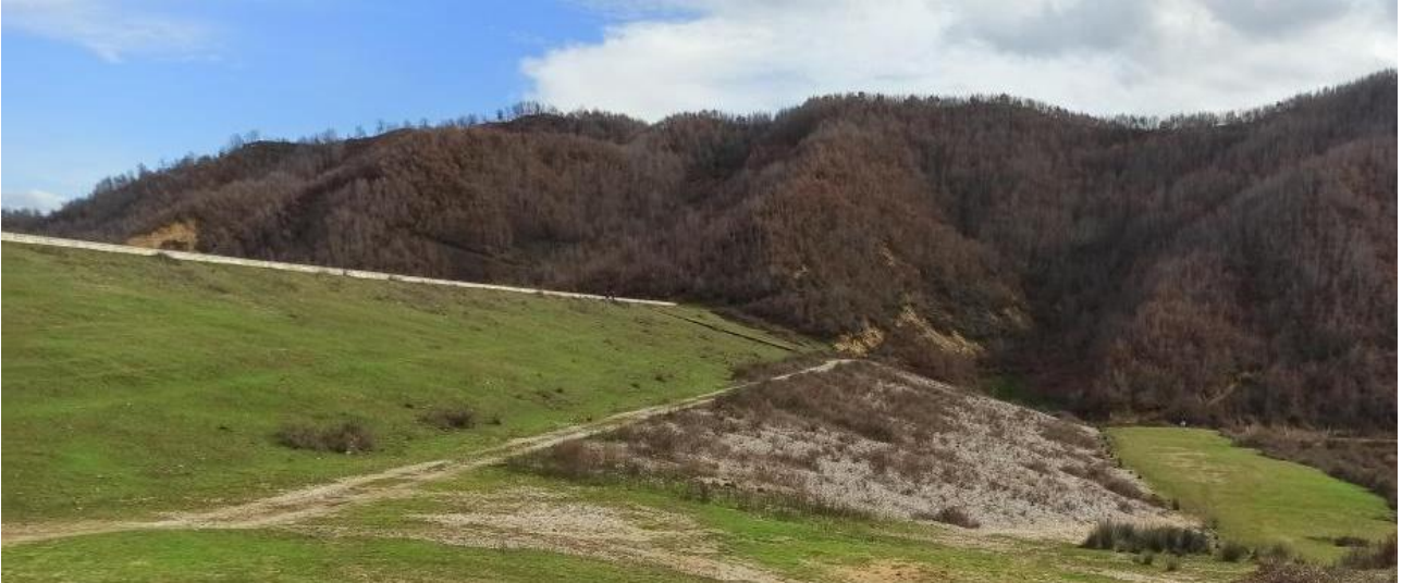
5- Diga dhe rezervuari ne Farke, Tirane, H = 29.0 m, Volumi i projektuar i Rezervuarit Vu= 8.0 milion m3
