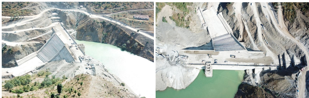
Pamje gjate Ndertimit te diges, 2018
