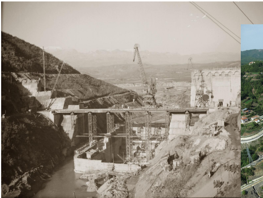
Diga Ulez gjate ndertimit, 1957
