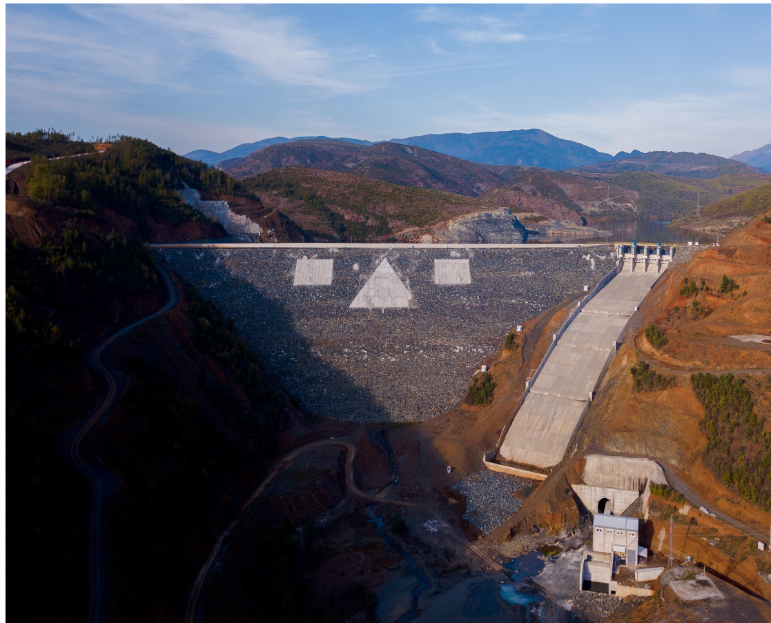
Diga e HEC Fan
