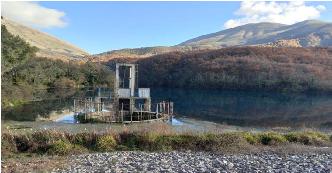
Figure 3-2 Shkarkuesi sipërfaqesor tip Tulipan i digës së Bistricës 1
