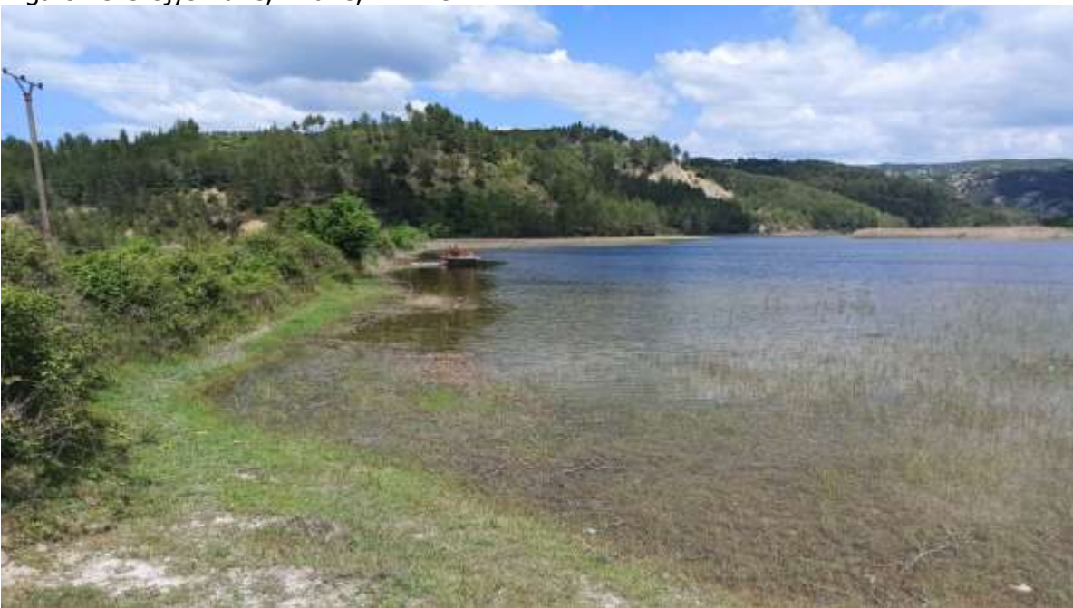
Diga e Peze Gjyslikane, Tirane, H = 29 m
