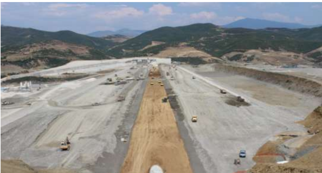
Gusht 2015, Gjate procesit te mbushjes se trupit te diges ne kuoten 150 mmnd
