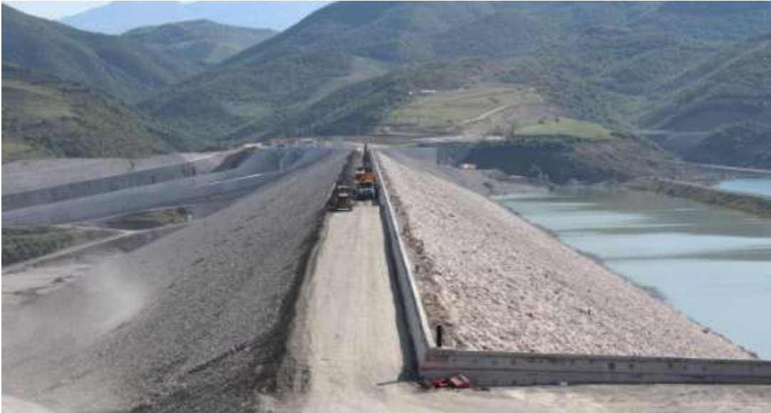
Maj 2016, Gjate procesit te mbushjes se trupit te diges ne kuoten 178 mmnd
