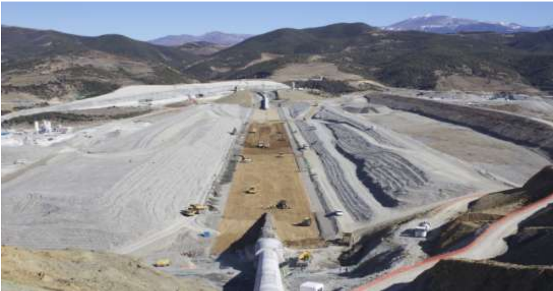
Shkurt 2015, Gjate procesit te mbushjes se trupit te diges ne kuoten 135 mmnd
