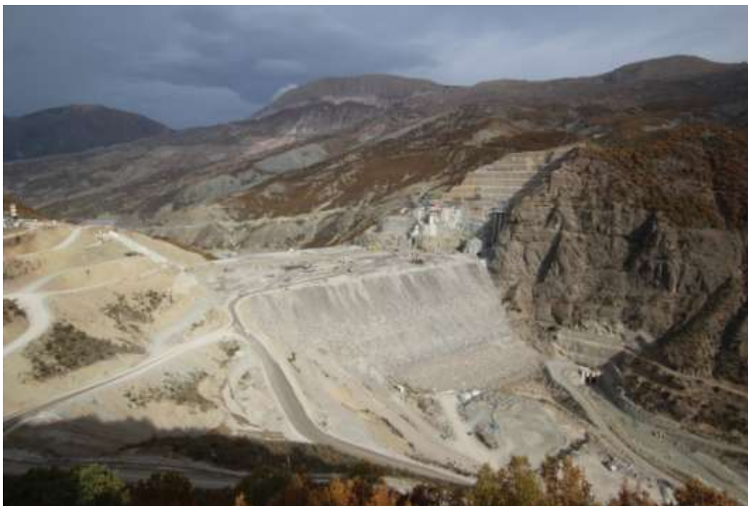
Gjate punimeve ne trupin e diges ne kuoten 605 mmnd
