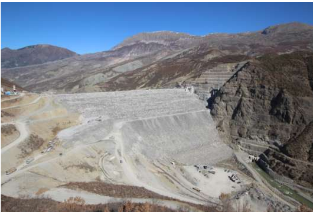
Gjate punimeve ne trupin e diges ne kuoten 650 mmnd
