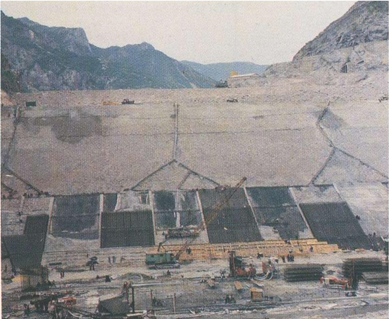
Gjate ndertimit te Ekranit Betonarme te diges se HEC Koman
